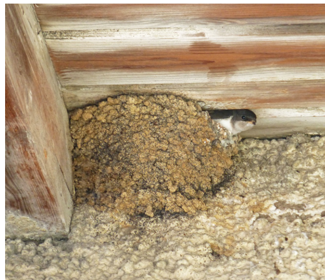
Typisches Fassadennest der Mehlschwalbe.
