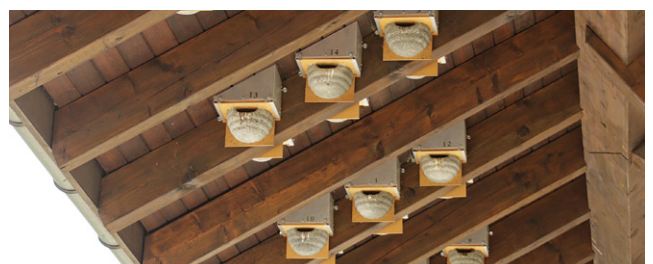
Vogelfreundlich – Kunstnester fassadenschonend an Querbalken montieren.
