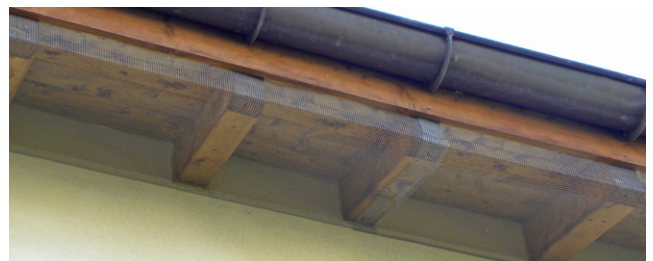
Vogelfreundlich – über heiklen Bereichen einen Fassadenschutz anbringen.
