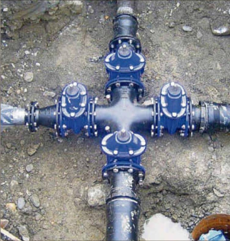
Wasserrohre mit Schiebern. Bild: zvg
