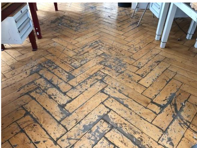
Bild 6: Bodenbelag in schlechtem Zustand
