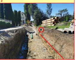
3. bestehende Sickerleitung über wasserführender Schicht
