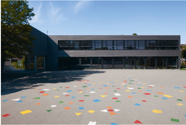
Bild 2: Ostfassade bestehender Gebäudetrakt B, Blick vom Pausenhof
